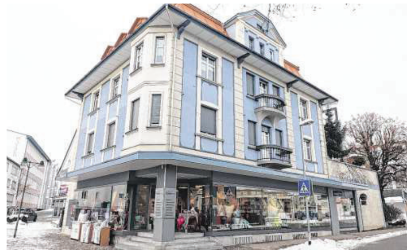
In den Jahren 1905 bis 1908 entstand das Gebäude von Betten Specht am heutigen Hutmacherplatz. Das Geschäft gehört zu den traditionsreichsten Handelsunternehmen im Westallgäu. Fotos: Olaf Winkler
